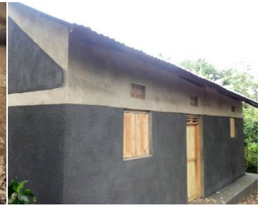
der Neubau am 01. Juli 2021
